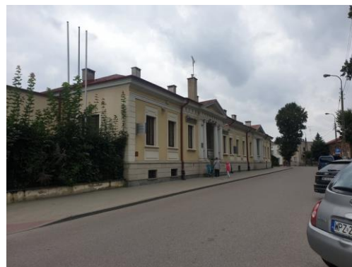
Rysunek 4. Widok na budynek przy ul. 3 Maja 13.
