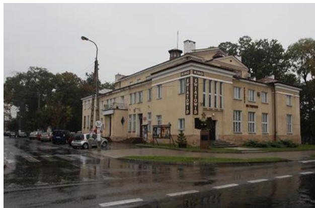
Rysunek 5. Widok na budynek przy ul. 3 Maja 16.
